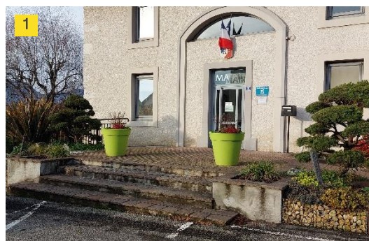
Abords de la mairie : parvis d'accès
