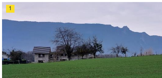
Opération immobilière en cours de construction (ouest du secteur)
